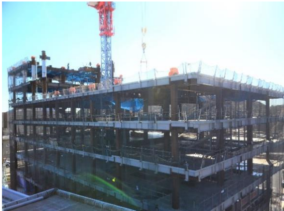
8階床の鉄骨工事に着手
