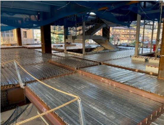
5階床までの柱・梁・床組みが完了
