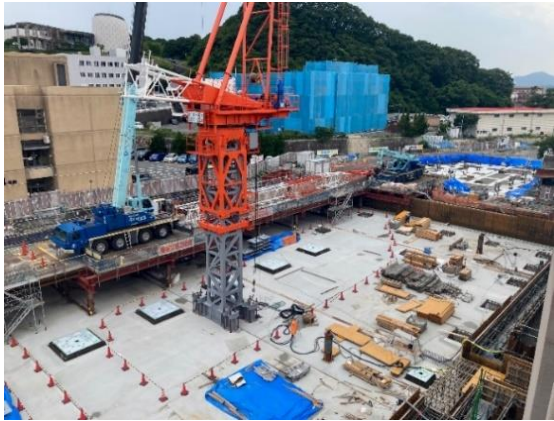
仮設タワークレーンの設置
