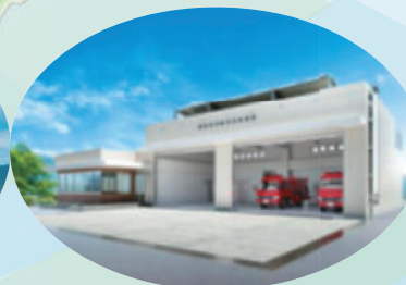
消防署東出張所完成
