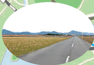
防府北基地東道路・ 華城小学校周辺道路の整備
