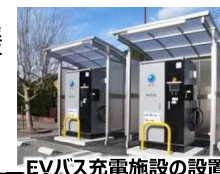
EVバス充電施設の設置
