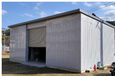
(大型防災倉庫)
