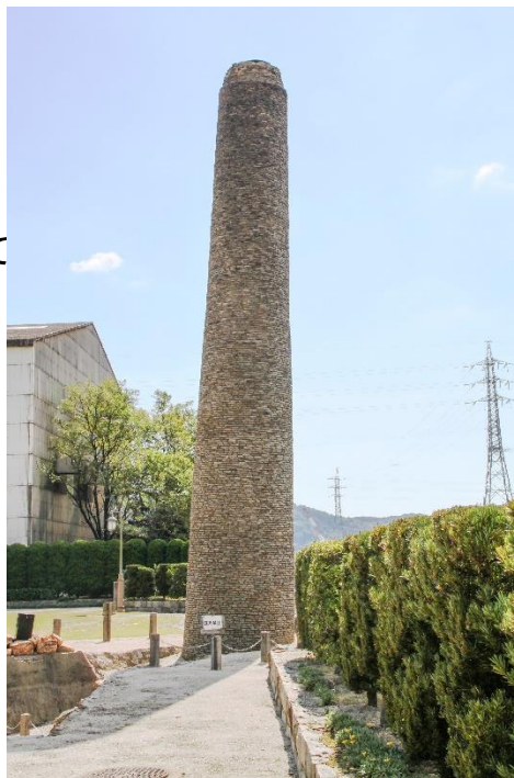
『三田尻塩田越中屋釜屋煙突』
