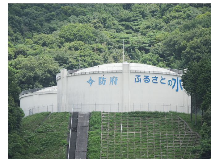
②人丸配水池
