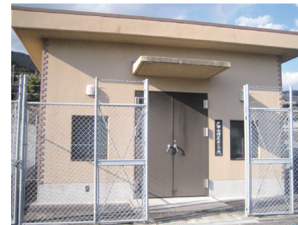
①戸田山増圧ポンプ所
