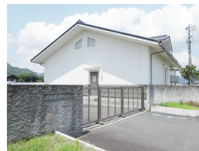
① 右田中継ポンプ場
