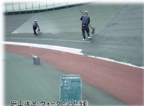
施工状況：ウォークトップ（緑）
