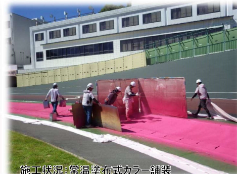
施工状況：常温塗布式カラー舗装
