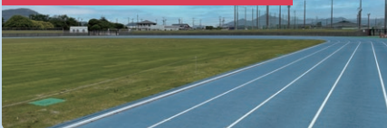
防府市スポーツセンター陸上競技場
