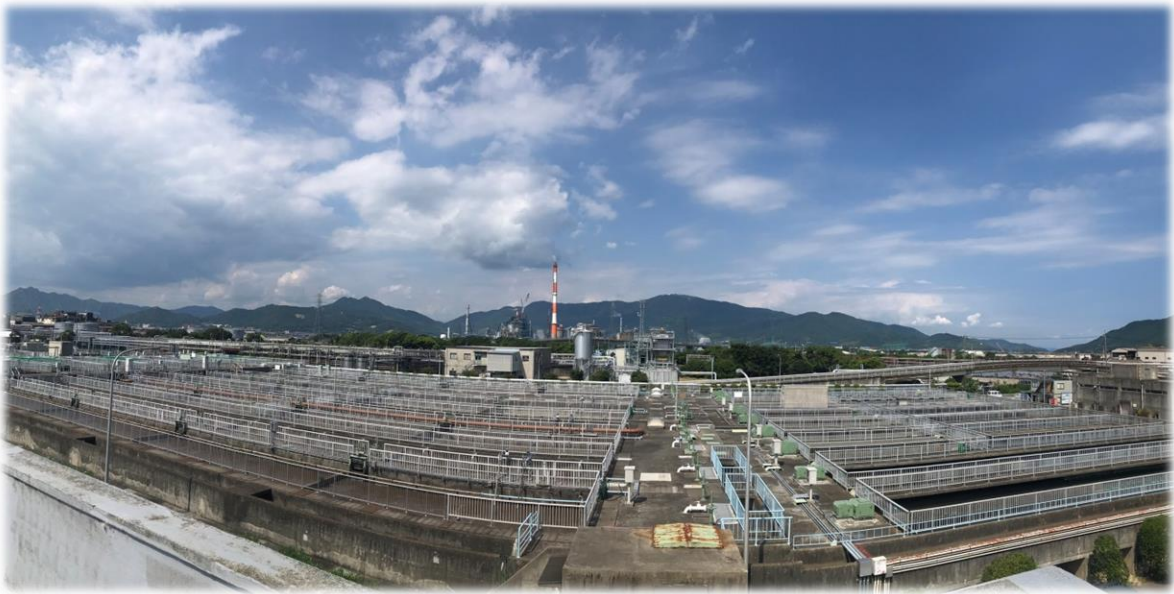
図－27 防府浄化センター
