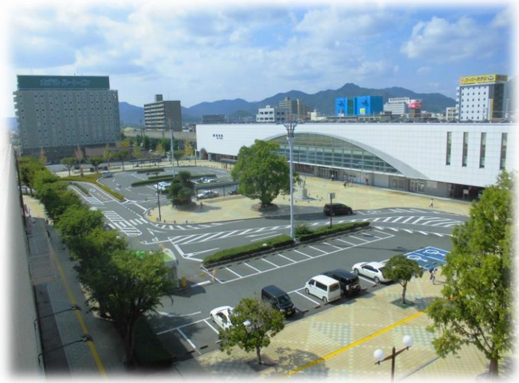
図－24 防府駅みなとぐち駅前広場
