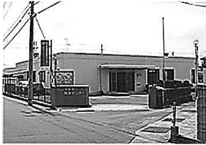
センターの外観
