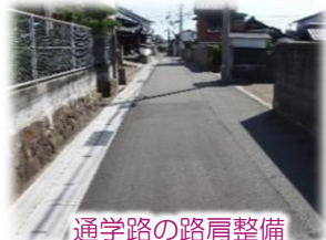
通学路の路肩整備
