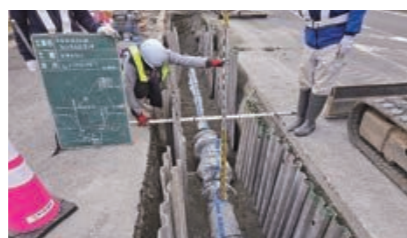
地震に強い配水管の設置
