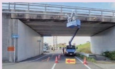
橋りょうの点検
