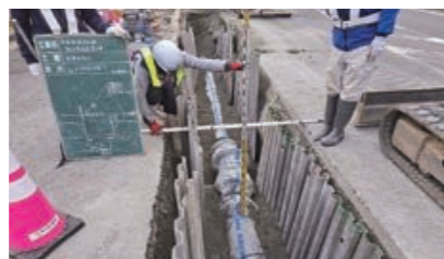
地震に強い配水管の設置
