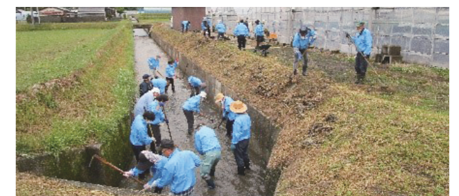
多面的機能維持・発揮するための共同活動(水路の泥上げ)
