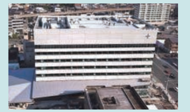
市役所新庁舎オープン (令和7年1月)
