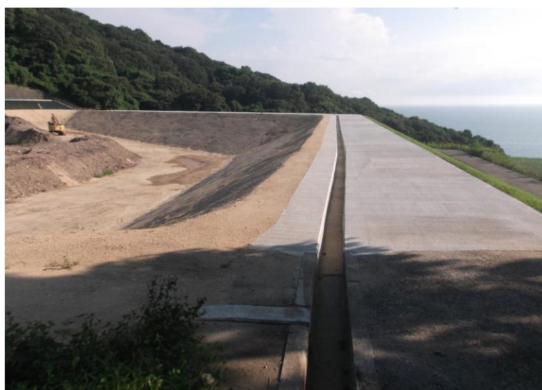
防府市一般廃棄物最終処分場
