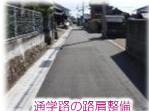
通学路の路肩整備
