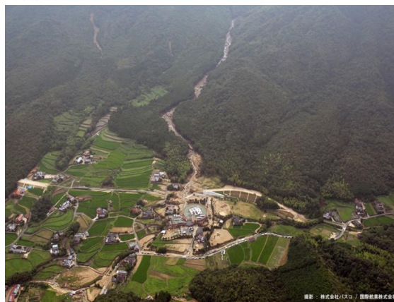
平成21年7月中国・九州北部豪雨による土石流被害 (真尾 特別養護老人ホームの被災)
