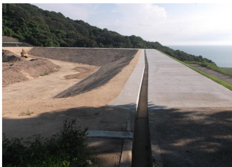
防府市一般廃棄物最終処分場
