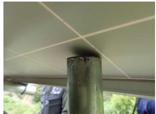
架台とモジュールの接近すぎ
