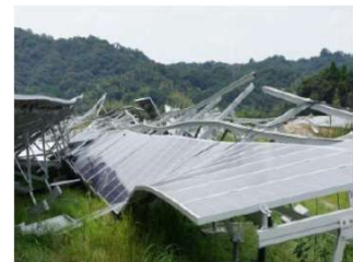
パネル飛散の例-2
