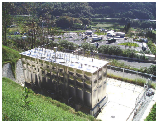
戸田山配水池
