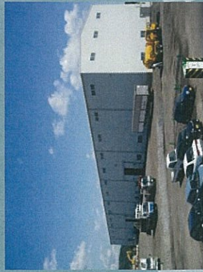
選別・前処理手解体
