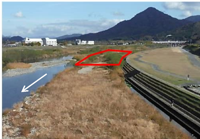
ワンド設置位置 (堆積、洗掘の影響が極力ない箇所を選定)
