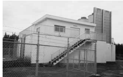
改良工事中の地神堂水源池
