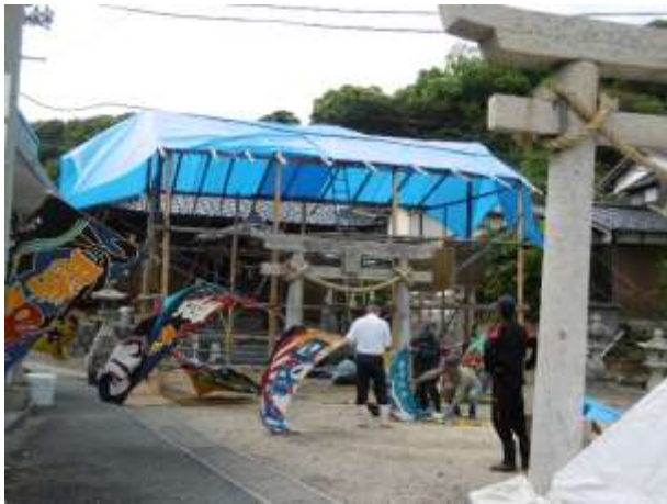
着々と進む、神殿の組み上げ
