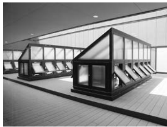
自然換気、自然採光（伊賀市）
