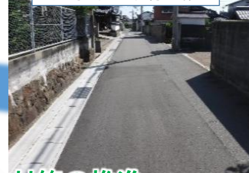
通学路の路肩整備
