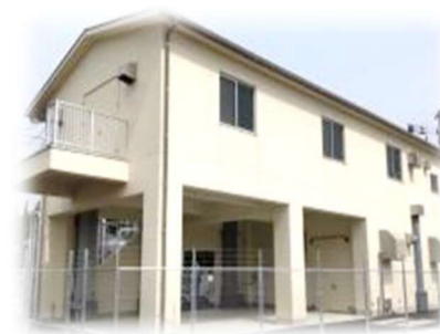
③地神堂水源地 (R3.3 更新)
