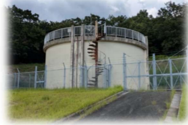
⑥上木部配水池 (S59.3 建設)
