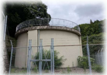
④富海配水池 (S63.3 建設)
