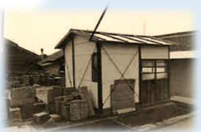
惣社増圧ポンプ所
