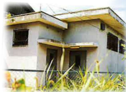
大道増圧ポンプ所
