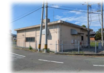
⑪大塚水源地 (H4.3 更新) (工業用水道事業)
