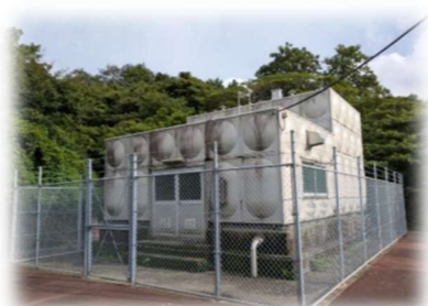
⑧勝坂低区配水池 (H15.3 建設)
