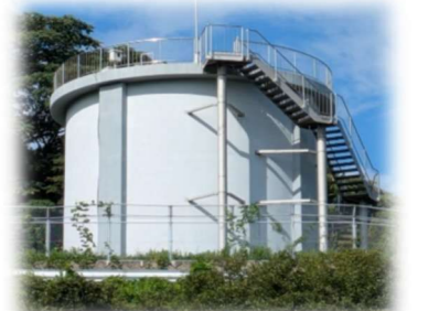
⑬西浦配水池 (H14.5 建設)
