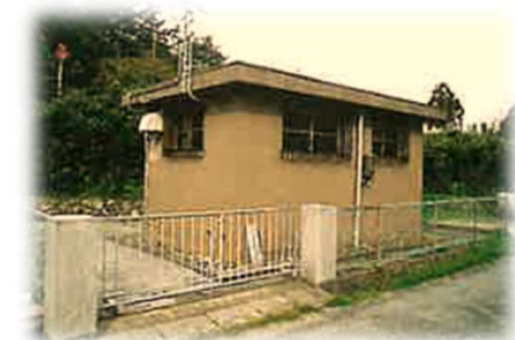
勝坂増圧ポンプ所
