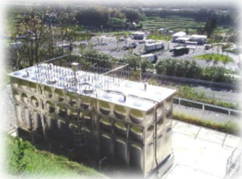
③戸田山配水池 (H17.3 建設)
