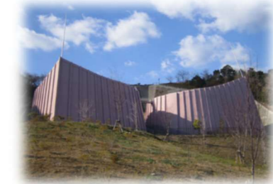
①桑山配水池 (H10.3 更新)
