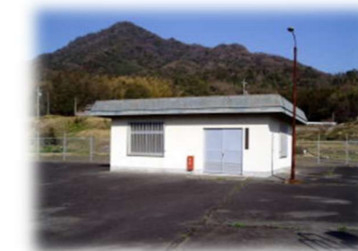
⑩上人丸水源地 (S57.3 建設)
