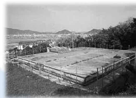
田島山配水池
