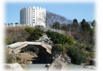
⑫佐野配水池 (S63.3 建設)
